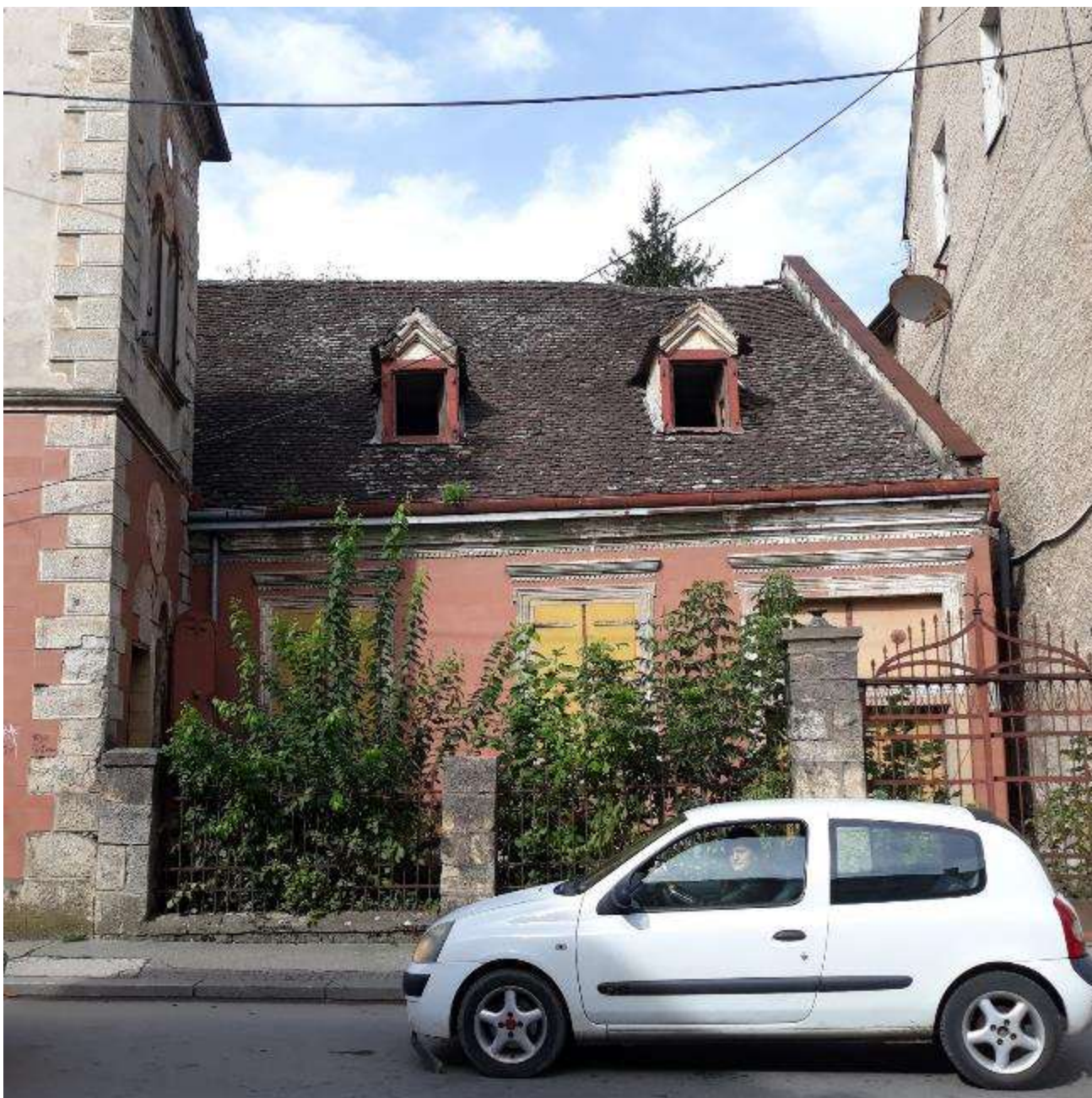
Сл. 13. Југо-источна фасада, 2022. (извор: Документација Завода)
